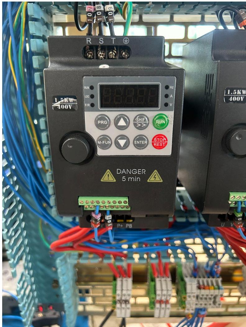
Pour accéder aux paramètres du variateur **CW100**, il faut appuyer sur le bouton **PRG**, naviguer avec les flèches **▲/▼**, puis valider avec le bouton **ENTER**.
